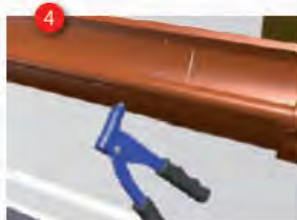
Заклепайте патентованными заклепками PREFA 4 x 10 мм, располагая их в крестообразном порядке (6 шт. заклепок для водосточного желоба \varnothing 100 мм, 8 шт. заклепок для водосточного желоба \varnothing 125 мм и \varnothing 150 мм, 10 шт. для водосточного желоба \varnothing 190 мм).
