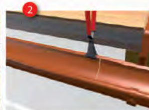
Соедините водосточные желоба в нахлестку, шириной до 8 см. Обожмите ребра желобов.
