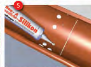
Дополнительно обработайте места крепления заклепками силиконом с внутренней стороны.
