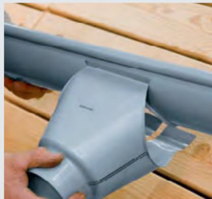
Навешиваем воронку на валик желоба. Загибаем заднюю планку крепления воронки.
