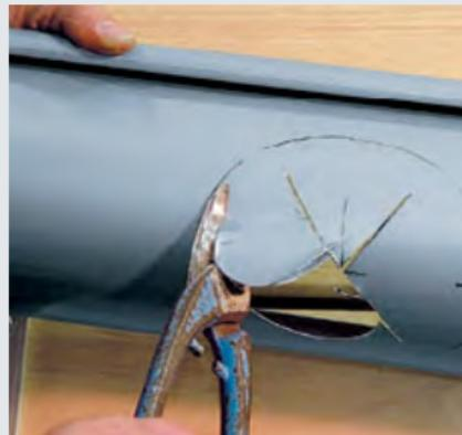
Вырезаем отверстие с меньшим радиусом внутри начертанного овала.
