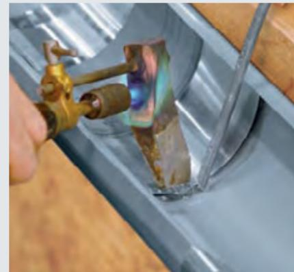
При нажатии и медленном перемещении паяльника паять компенсатор с двух сторон.
