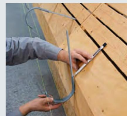
Натяжение шнура для выравнивания других крюков. Проверка уклона желобов с помощью уровня. При необходимости крюк подогнуть.
