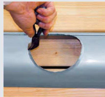
Поднять бортик 5 мм. Помощью загиба кромки наружу.
