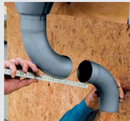
Длину доборной трубы выбрать таким образом, чтобы водосточная труба расположалась на мин. 20 мм от фасада.
