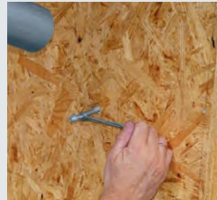
Сверление отверстия. Забивание подходящего дюбеля.
