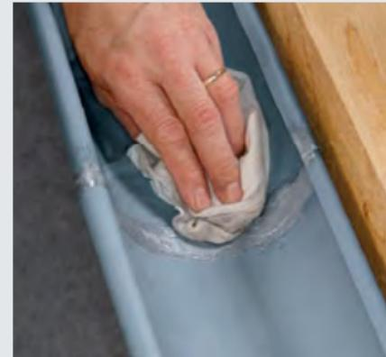
Очистка паяльного шва от остатков паяльной жидкости и копоти с помощью влажной тряпки.
