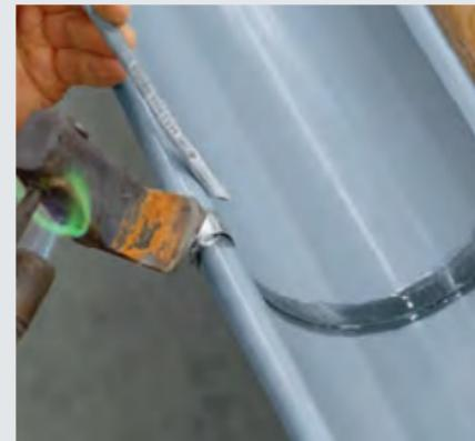
Процесс пайки начинать с валика желоба. Продолжение пайки...
